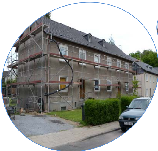
Fassaden- und Dachdämmung „Heinrich-Heine-Str.“
