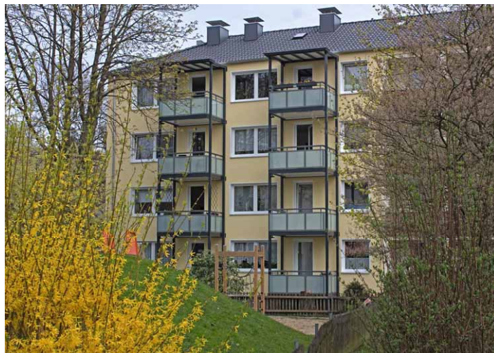
An der Seilerei 1+3 nach Abschluss der Sanierung
