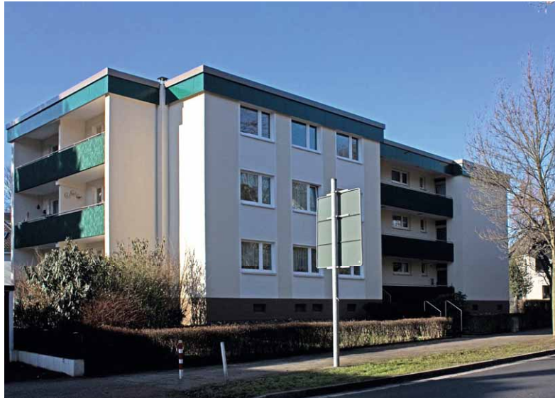
Graf-Zeppelin-Str. 5+7 (Dach, Fenster, Fassade)
