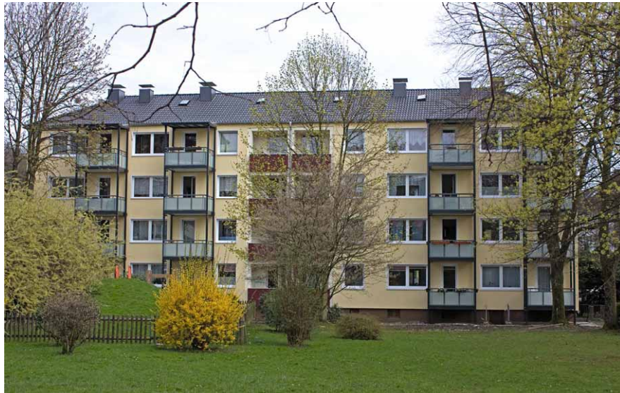
„An der Seilerei 1 + 3“ nach der Modernisierung 2009
