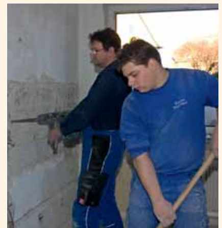
Mitarbeiter Walter Depping (l.) und David Hoffmann bei Installationsarbeiten.
