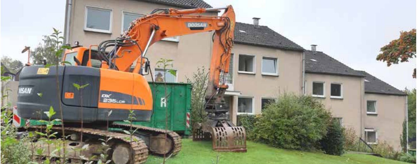
Der Bagger steht schon vor den Abrissgebäuden, die derzeit innen entkernt werden.
